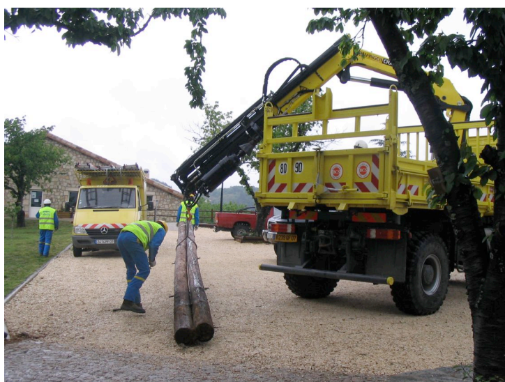
Dépose de poteaux bois à FABRAS.
